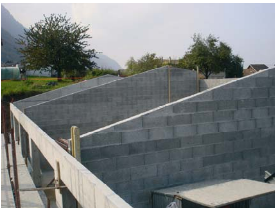
Avant la pose de la charpente, vue en direction de Meillerie.
