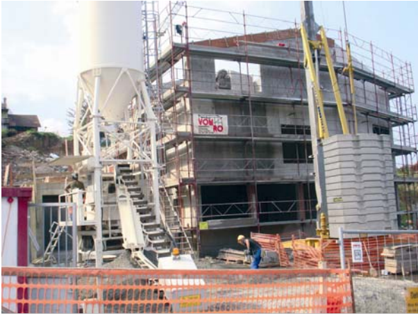
Fin de la maçonnerie en octobre 2007
