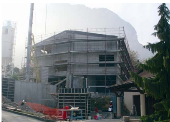
Une école en construction qui avance ...
