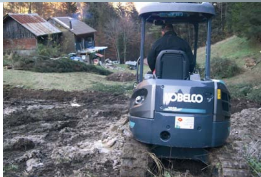
Des travaux pour pouvoir capter la source et la sécuriser.
